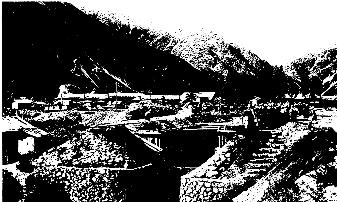
（南成）況狀出搬石鑛山鐵原利
