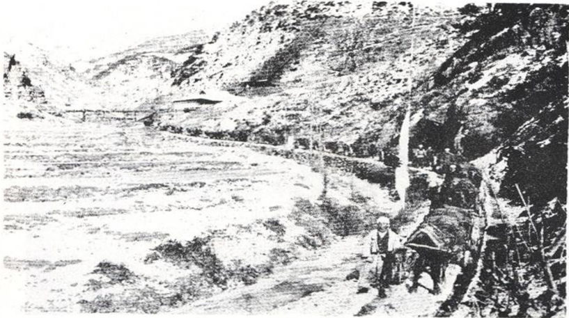
てしに半里八迄驛同永場車停りよ元山) 況狀の搬運石鑛るけ於に山鑛明月野山 の居住間同永一元山の搬運半・農半は搬運の此。るあで 鑛八十七圓三は貨運噸 (るあで名百二約は數夫車搬運の事從搬運の此は尙。るれば行りよに夫車半
