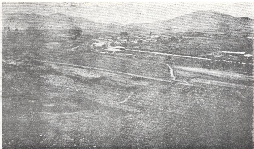
之はに前手の路道てしに場堀探山號一(は方左洛部) 山鐵浦二兼郡州黃道海黃 (るあで石鑛はのるあてし積堆に下右眞寫,りあ路綫道鐵の條二てし行平と
