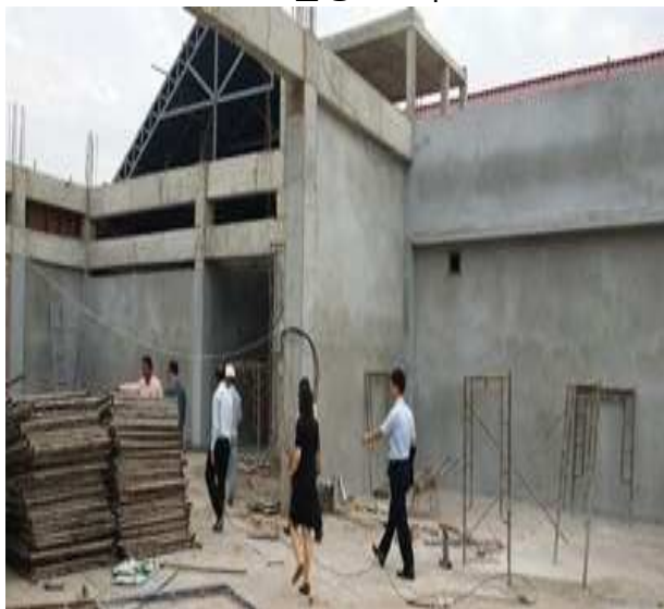
<신축 청사 건설 현장 방문>
